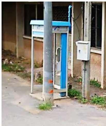
ภาพที่ 5 : ตู้โทรศัพท์ TOT ที่ใช้ภายในชุมชนตลาดหม่อมเจ้า
